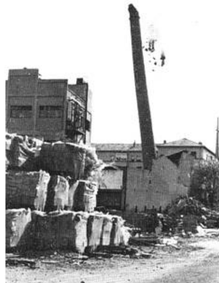
Fig. 3: Demolición con explosivos
